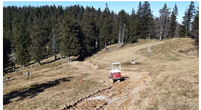
Arbeiten am Weg vom Gheist zur Alp Roten
