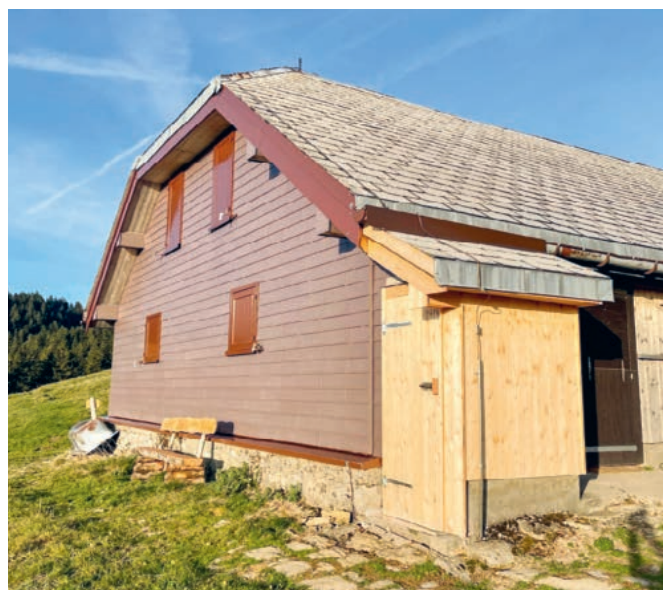
Sanierte Aussentoilette im Gheist
