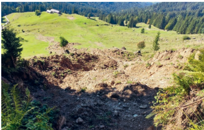
Blick von der Anrissstelle Richtung Mittelwengi
